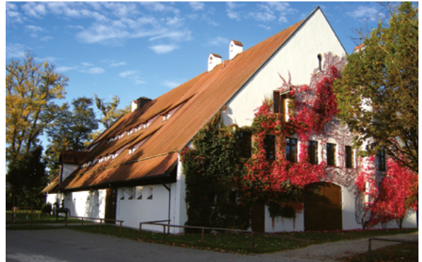
Das Zeughaus des Vereins „Die Förderer“
